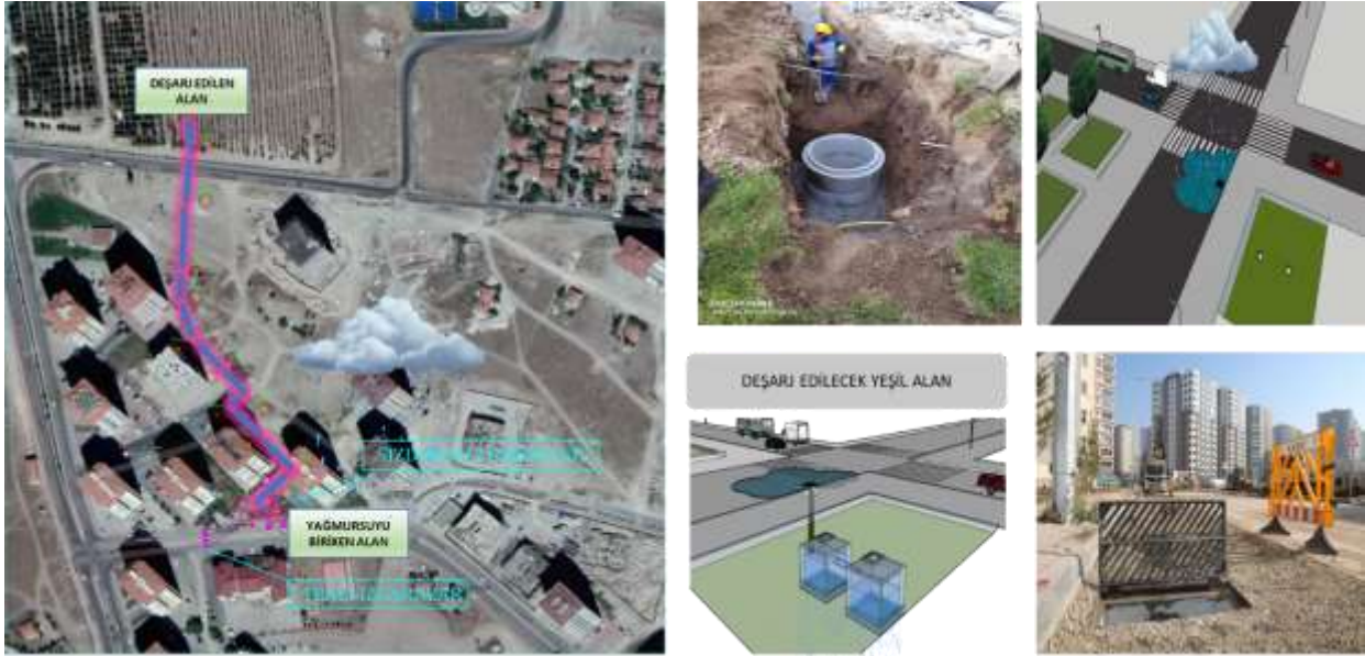
Şekil 6. KASKİ çökertme baca uygulaması
