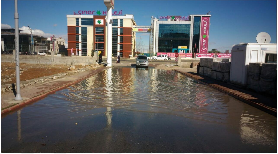
Şekil 3.2 : Çalışma alanında geçmişte yaşanmış taşkın
