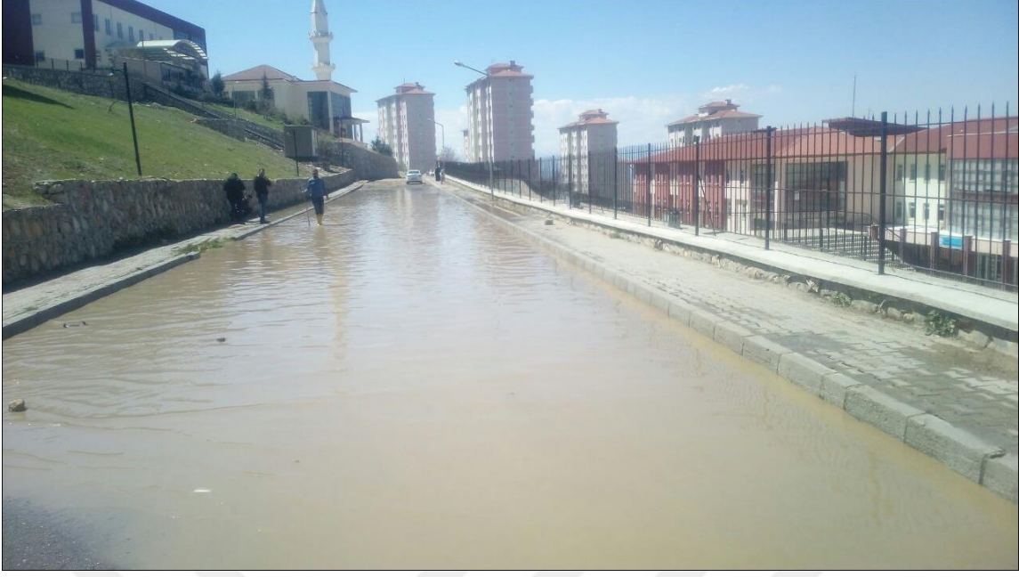
Şekil 3.3 : Çalışma alanında geçmişte yaşanmış taşkın
