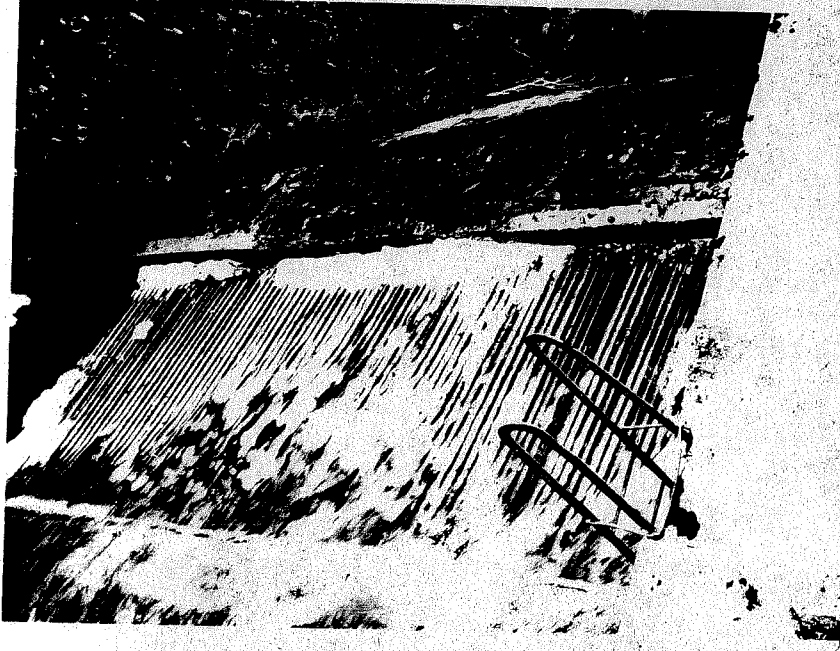
Şekil 2. Bağlama ızgarası ve granit kaplaması
