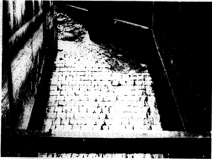
Şekil 9. Cimi1, bağlama kaplamasındaki aşınmalar
