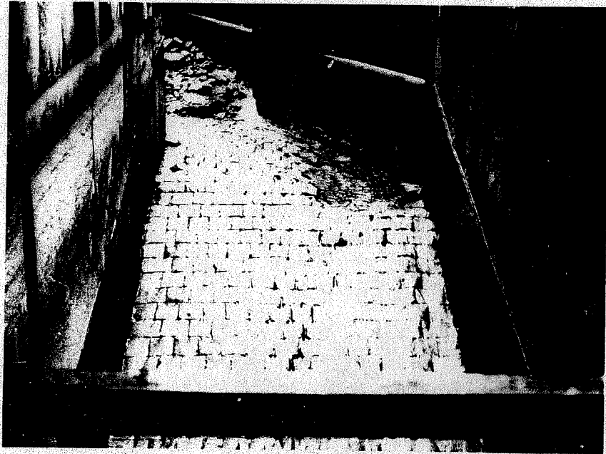
Şekil 9. Cımlı, bağlama kaplamasındaki aşınmalar
